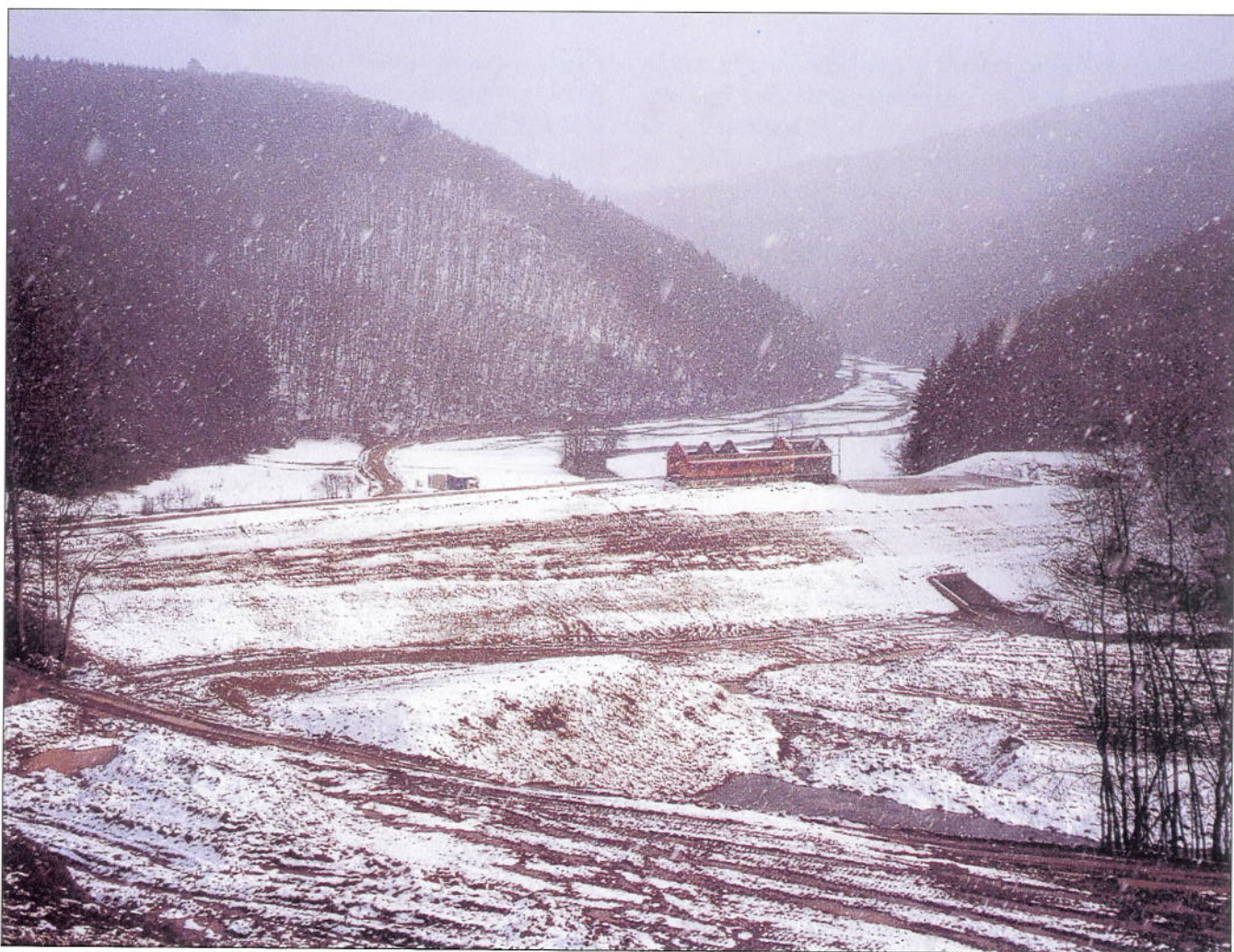
En fin 1998 les travaux furent bien avancés mais le chantier fut arrêté en hiver durant de longs mois.
