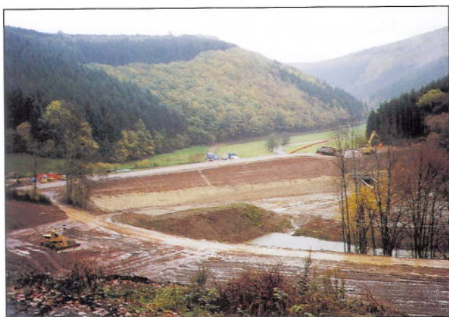
Vues d'ensemble sur le corps de digue en cours d'achèvement. En avant-plan de la photo gauche on reconnaît l'emplacement d'extraction de terres et pierrailles
