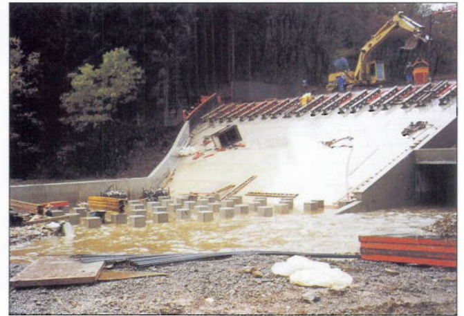
Schalungsarbeiten am Grundablaß (links). Arbeiten am Notentlastungsüberfall mit anschließender Rampe in Beton der sodann mit Muttererde bedeckt wurde (rechts).
