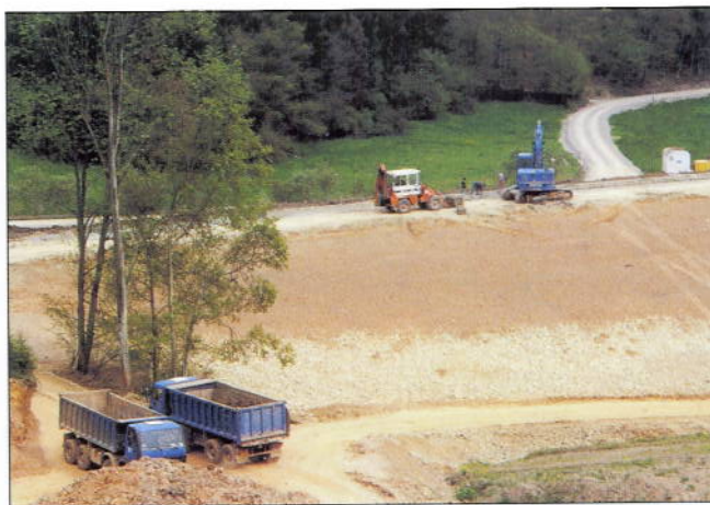
Gesamtansichten des fast fertiggestellten Dammkörpers. Im Vordergrund von Foto links erkennt man die Boden- und Gesteinsentnahmestelle
