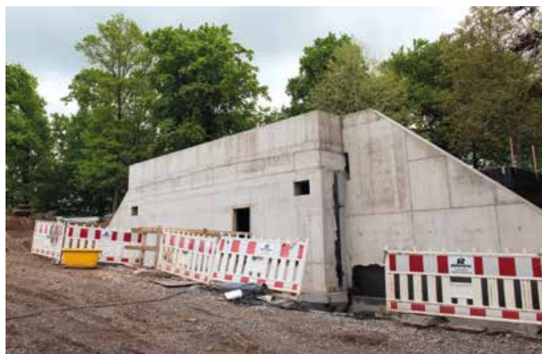
Auf dem Knäppchen wird ein weiterer 500 m 3 fassender Behälter gebaut. (Photo: Marco Brachtenbach)
