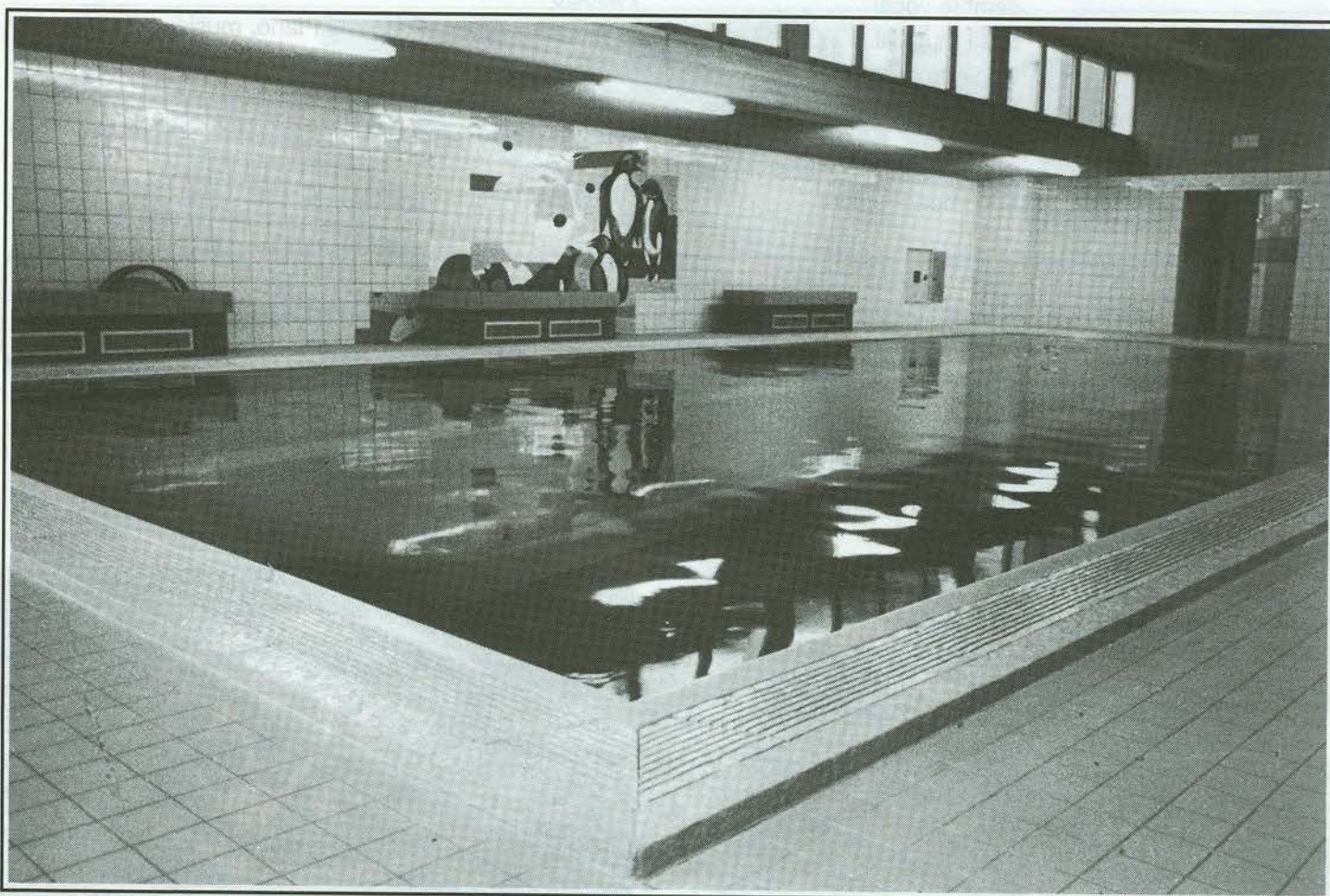
Ecoles primaires: Nouvelle installation de la piscine
