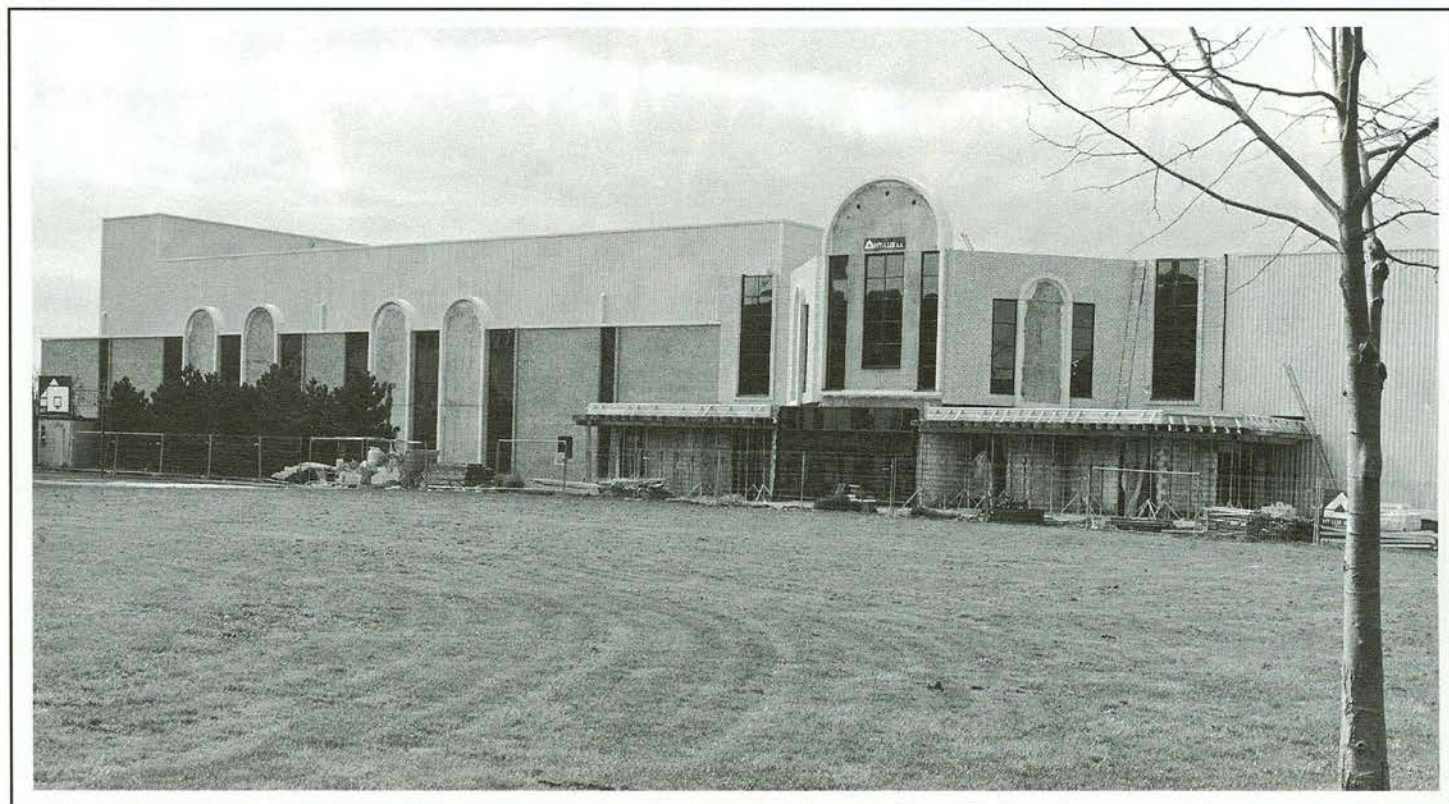
15. April 1995: Die neue Sporthalle nimmt Gestalt an.
