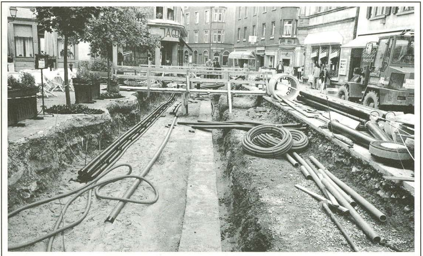
Am 10. Mai 1995 begannen die Arbeiten an der Fußgängerzone
