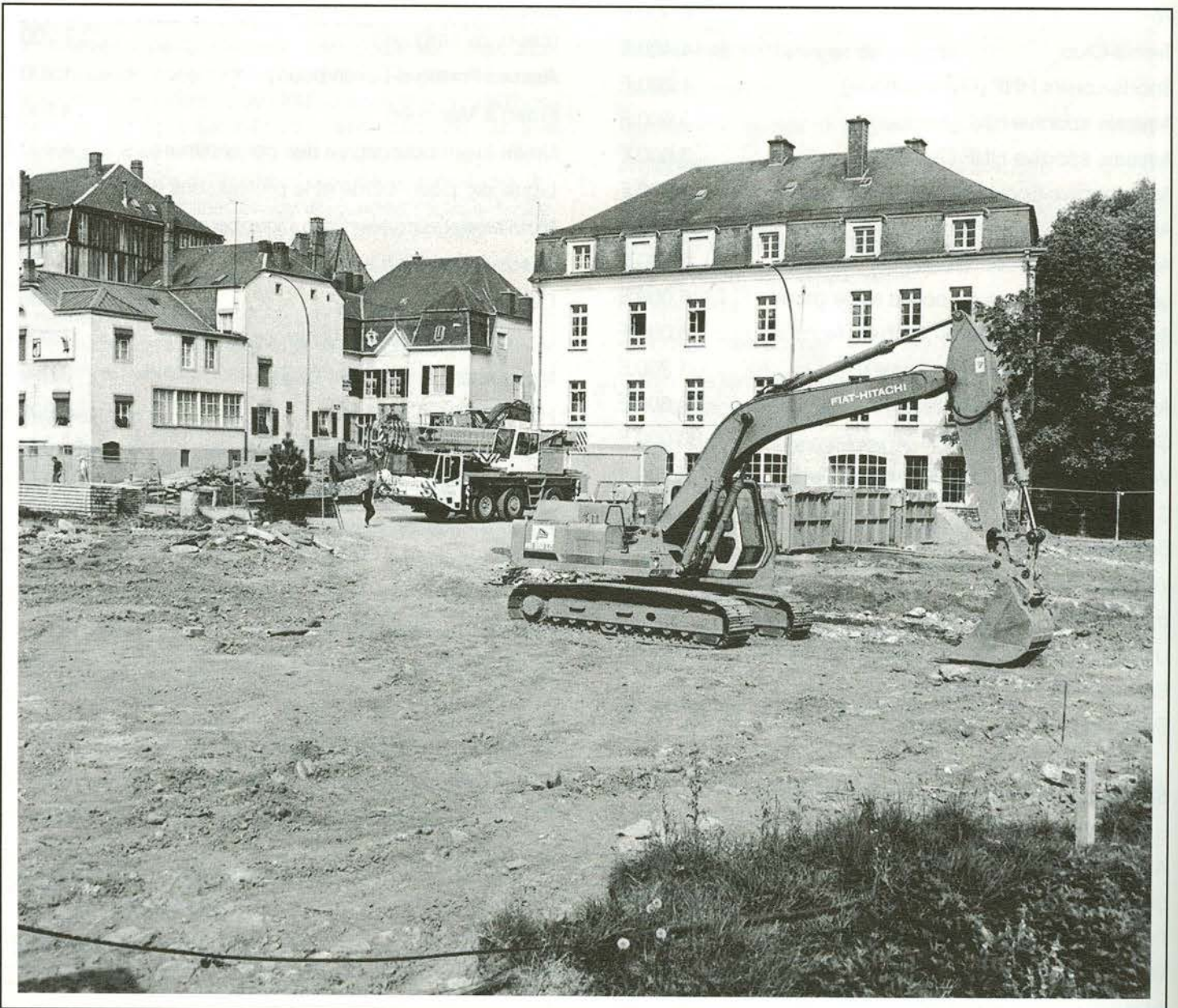
Juni 1995: Baubeginn am Kulturzentrum
