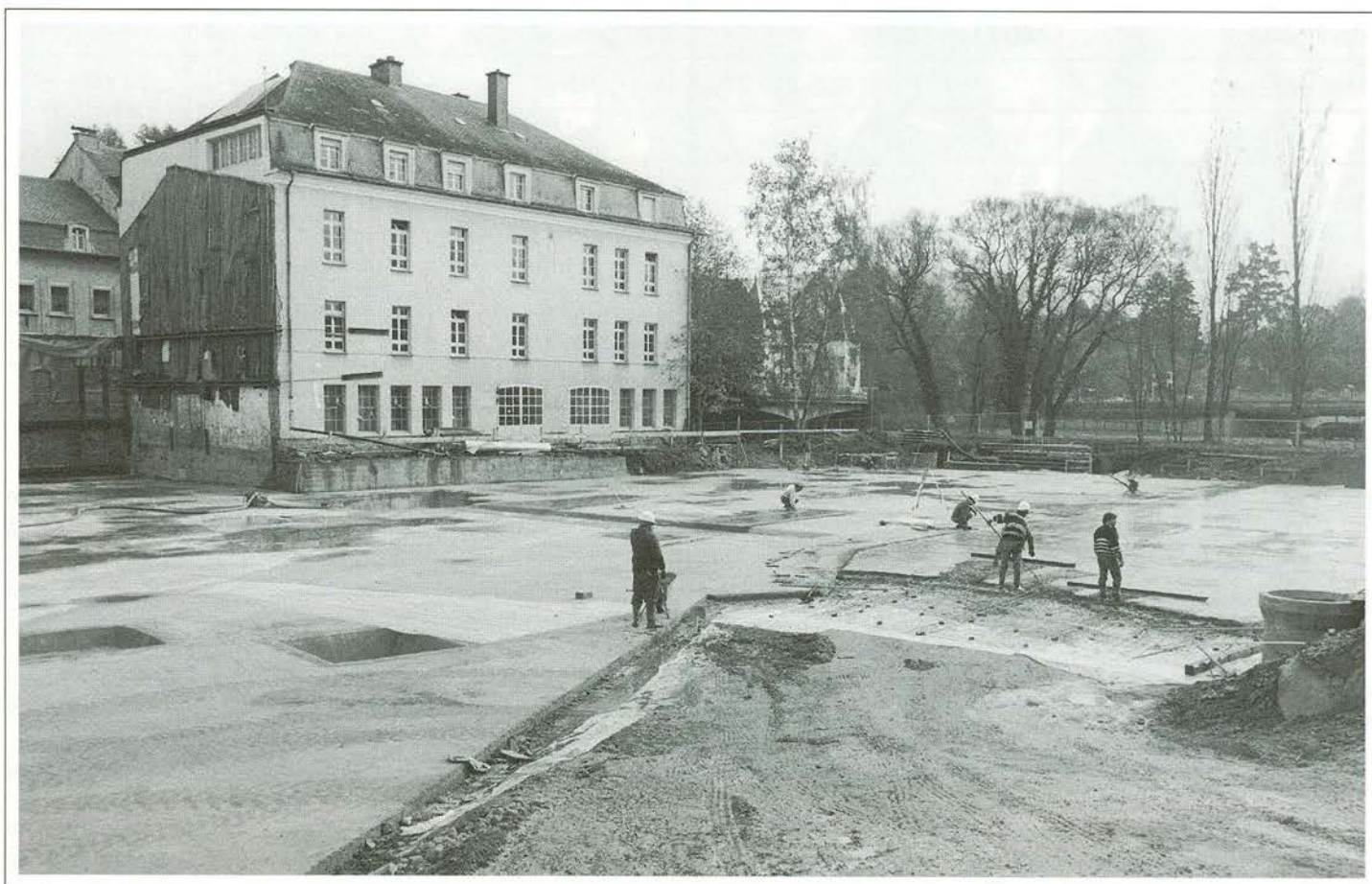
Mitte November 1995 wurden mit dem Auftragen der Betondecke die Fundamentarbeiten zum neuen Kulturzentrum abgeschlossen.
