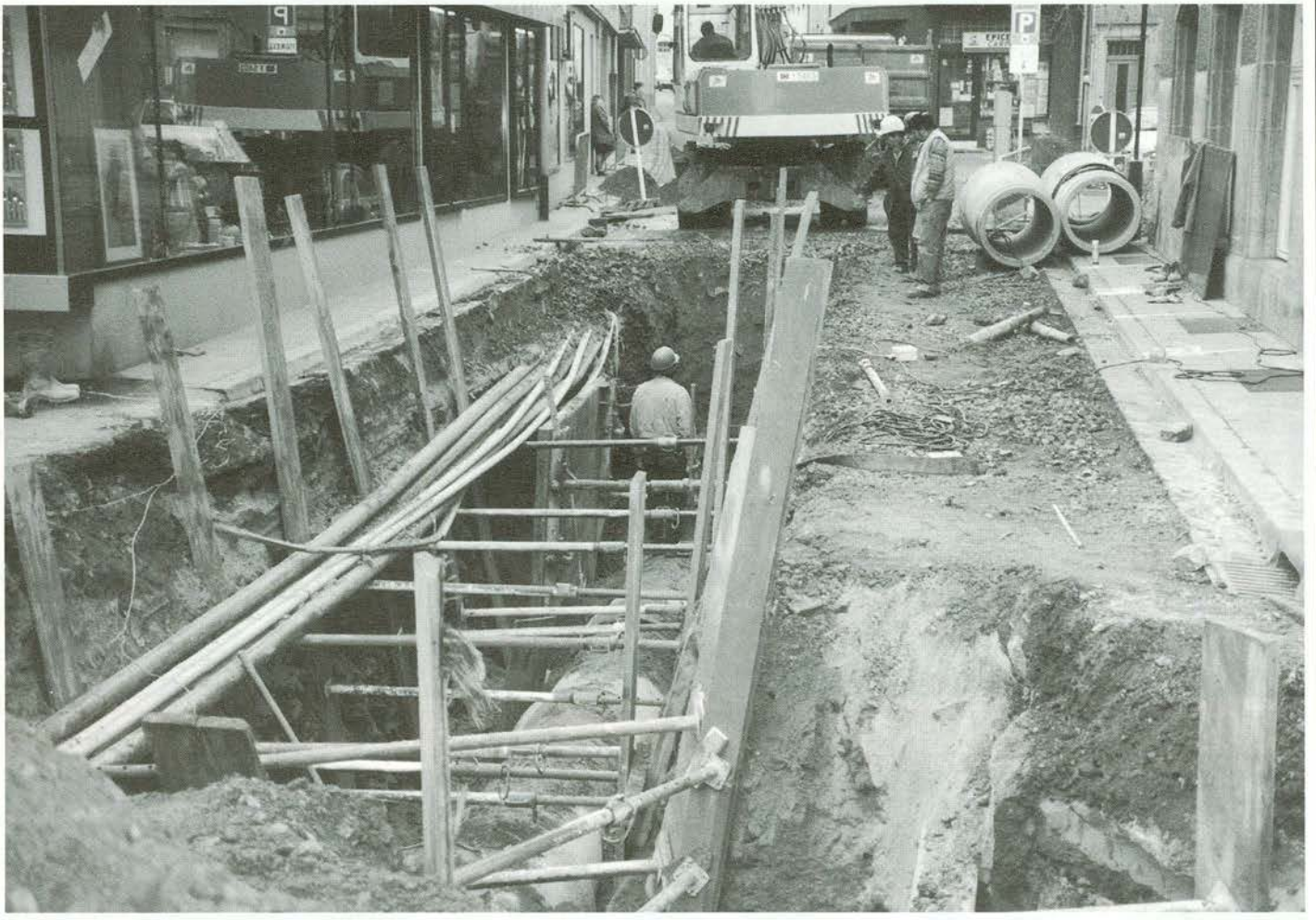
Erdarbeiten zur Erneuerung des Hauptkanals. (I)
