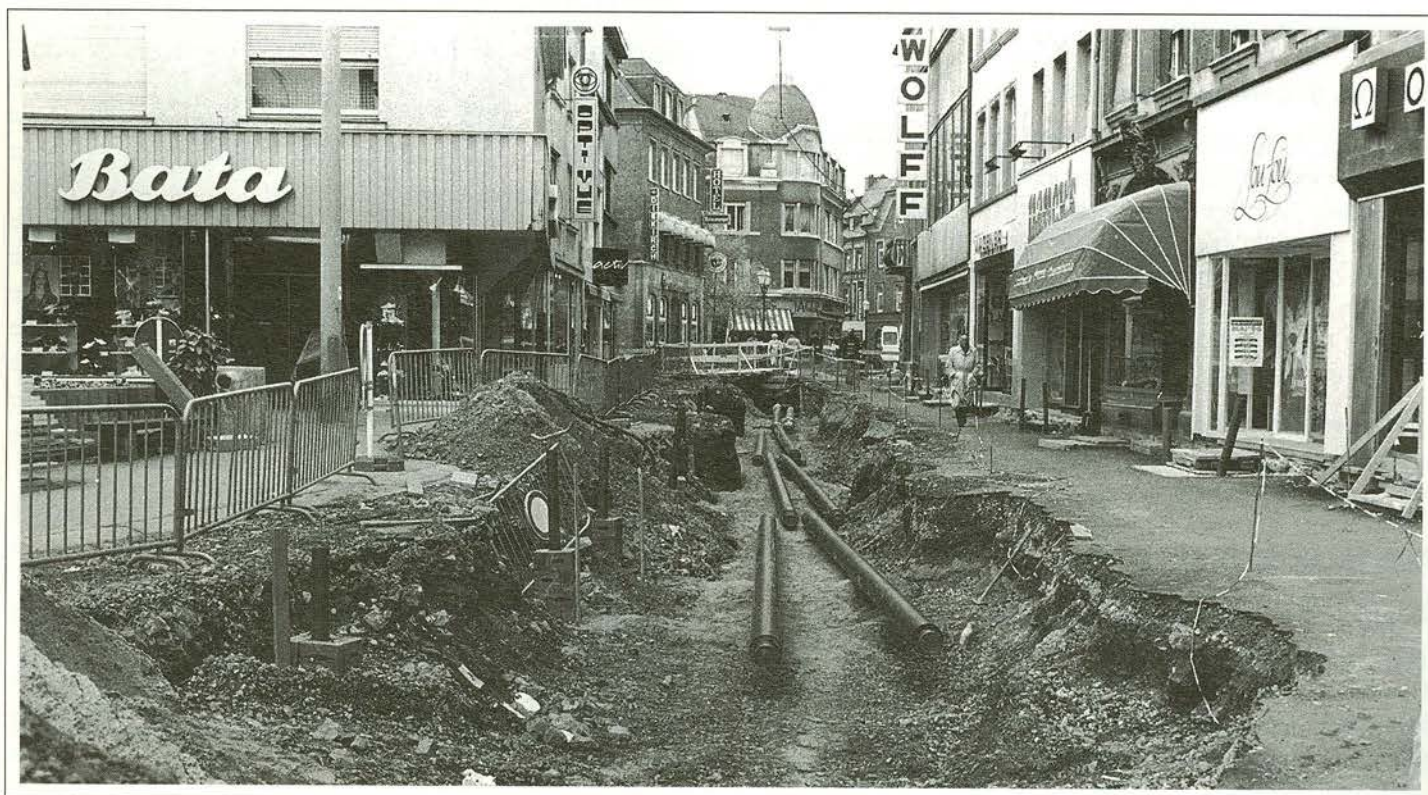
Baubereich II: Die letzten Anschlüsse werden verlegt (Mai 1996).
