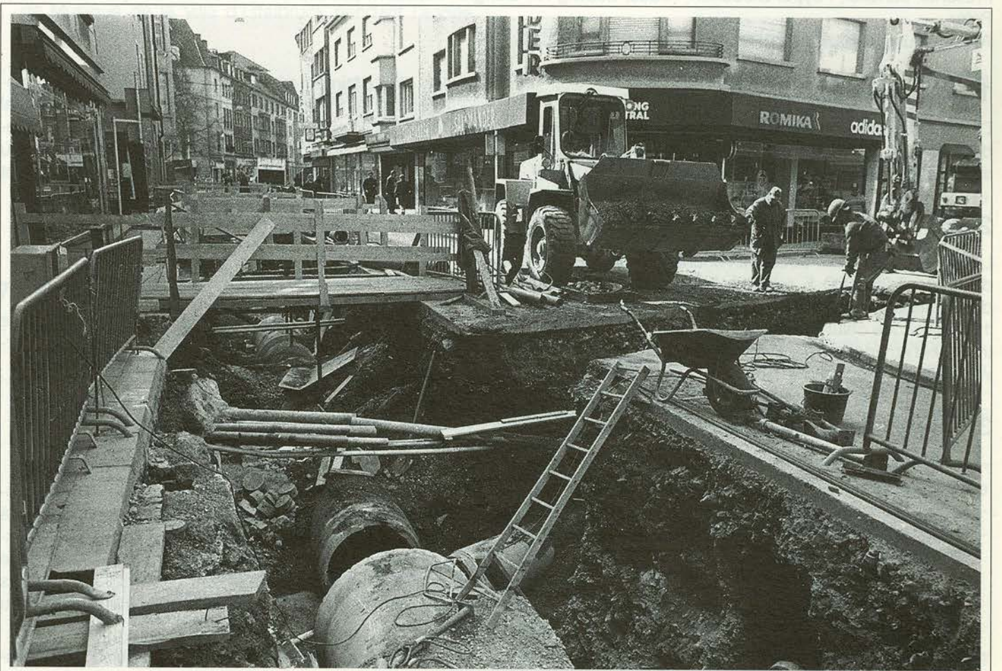
Im Bauabschnitt IV herrscht Hochbetrieb (Mai 1996).
