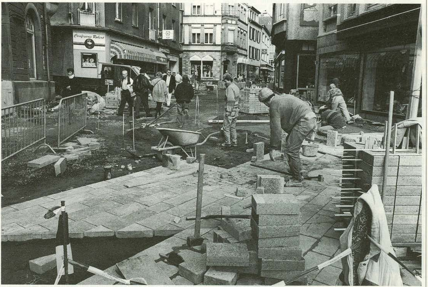
Baubereich I: Die Fußgängerzone nimmt Gestalt an (Oktober 1995).
