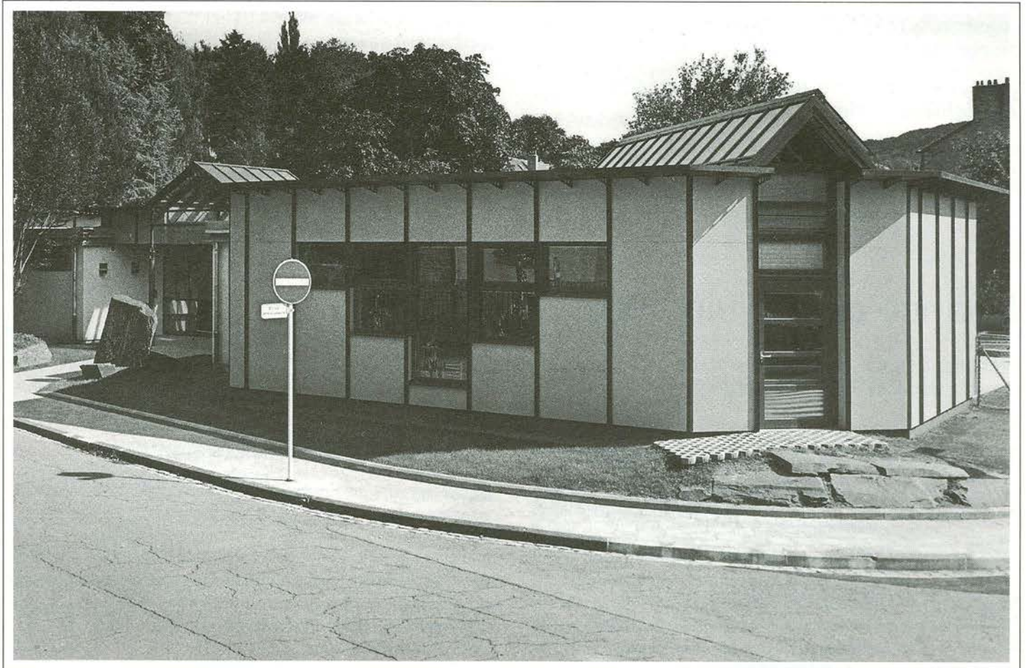
Den Ausbau vun der Spillschoul am Hiirzebiërg.
