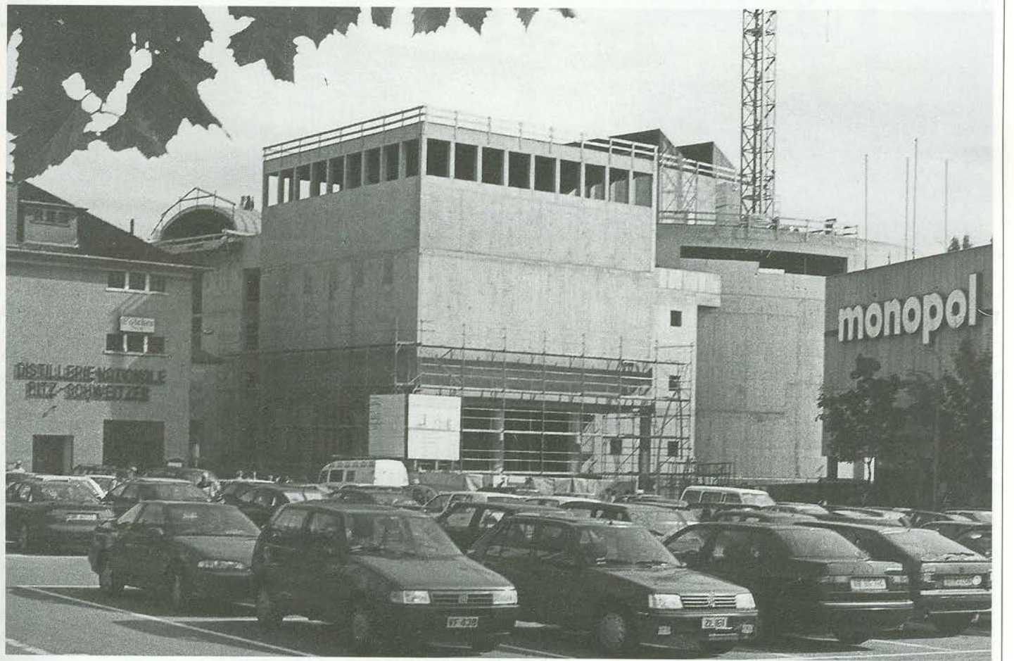
Die baulichen Fortschritte am Eitelbrücker Kulturzentrum seit dem 24. Juni 1996 (Bild oben) sind nicht zu übersehen. Die untere Aufnahme zeigt den Stand der Arbeiten am 14. September 1997. Das Richtfest konnte bereits am 6. Juni 1997 gefeiert werden.
