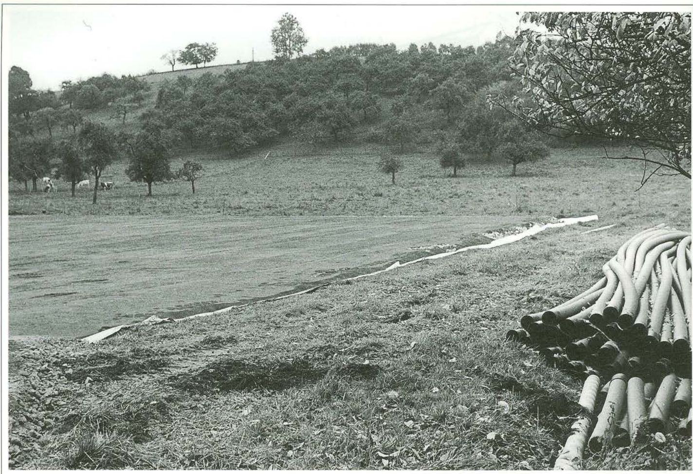
Das Baugelände der neuen Ettelbrücker Klinik kurz vor dem ersten Spatenstich.
