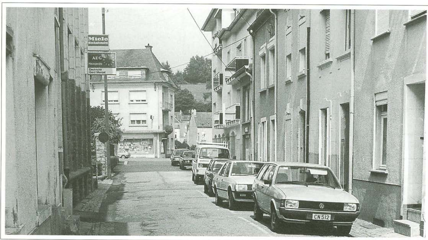
Die Rue Dicks vor ihrer Instandsetzung.
