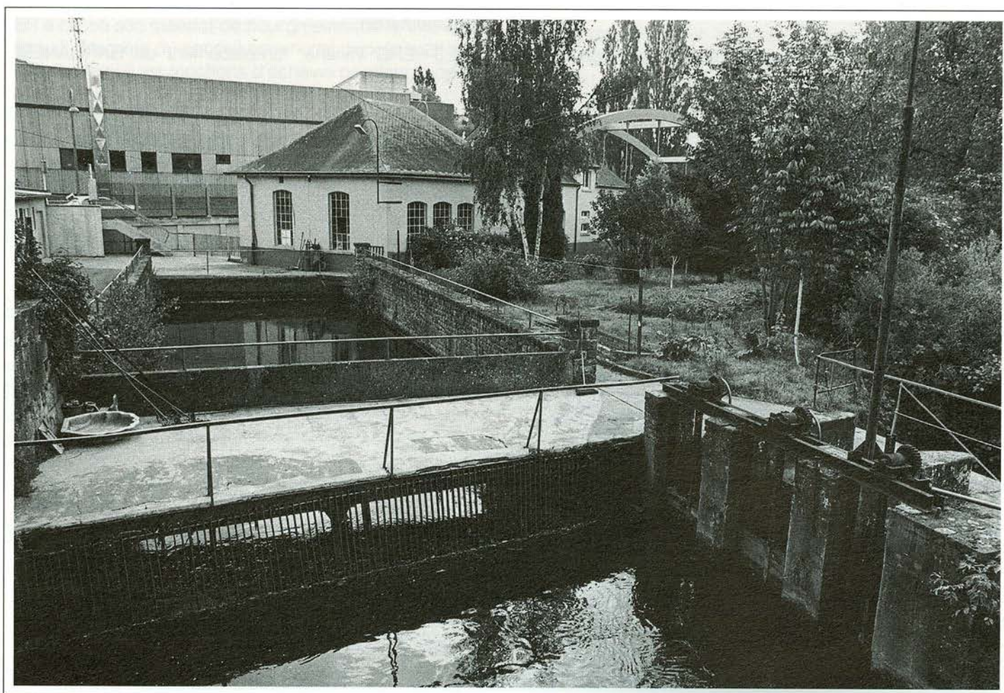
Juli 1996: Turbinenhaus am Wehr der Alzette kurz vor dem Abriß.
