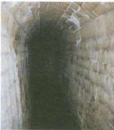
Trinkwasserquelle in Rollingen/Mersch
