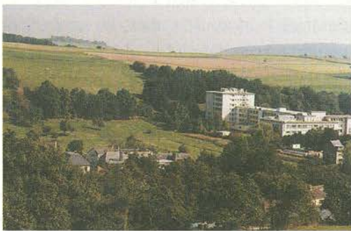
Octobre '98, un mois avant le début du chantier. ▲
