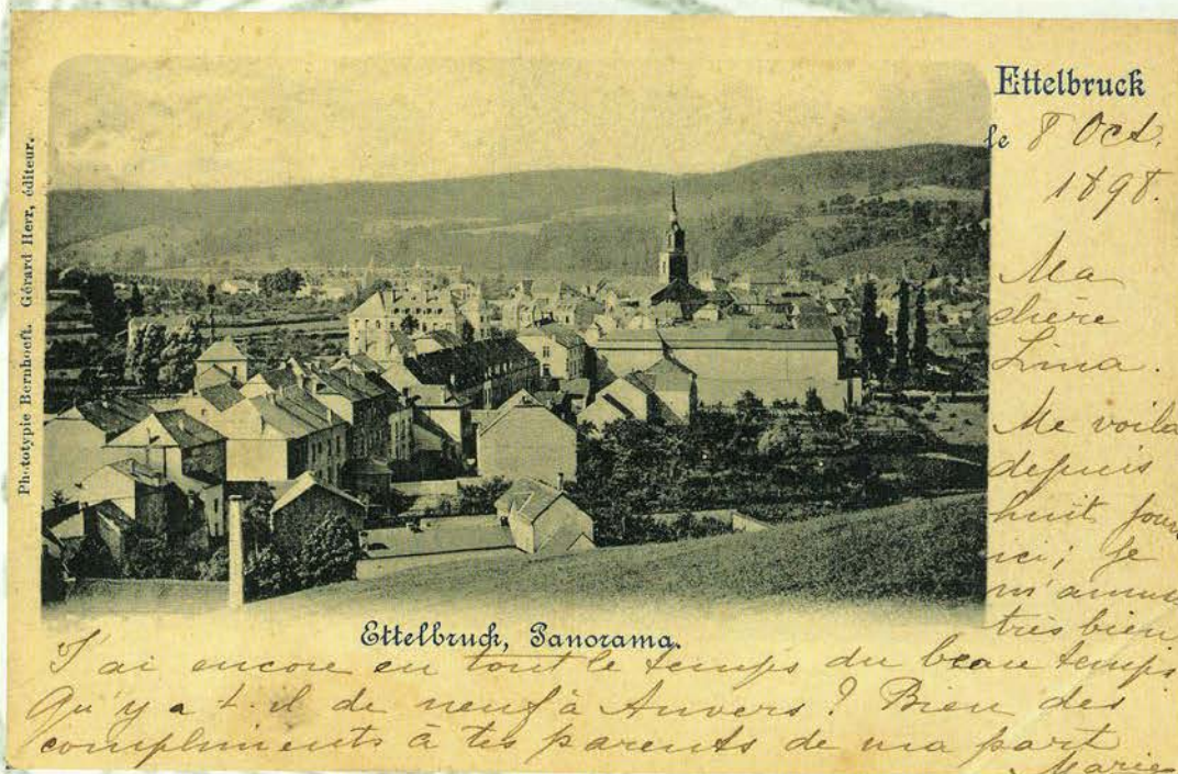
Diese beiden Phototypien von Bernhoeft wurden von Gérard-Herr herausgegeben. Vor der Kirche sieht man den Giebel der früheren Ackerbauschule.
