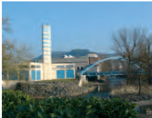
Centrale de cogénération
