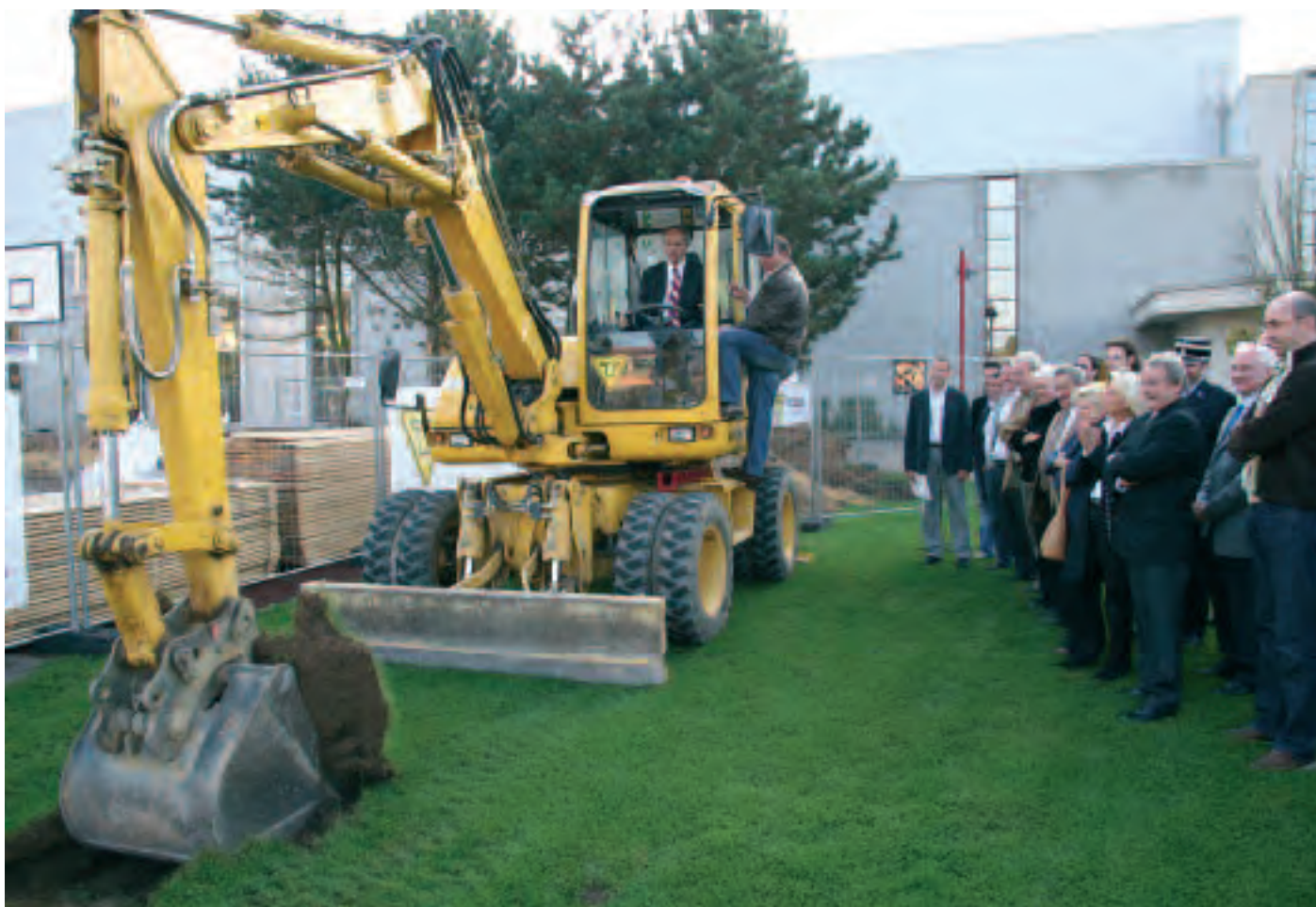
Premier coup de pelle du nouveau hall de gymnastique 15/10/2007
