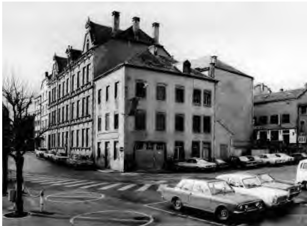
Das 1884 erbaute Werksgebäude kurz vor dem Abriss
