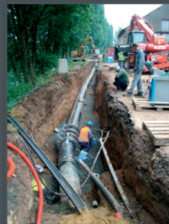
Conduite de refoulement
