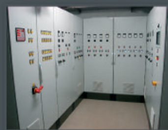
Installations électriques : télésurveillance
