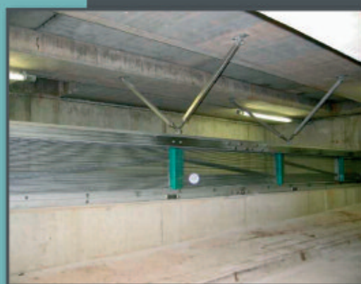
Dégrilleur avant déversement vers l'Alzette
