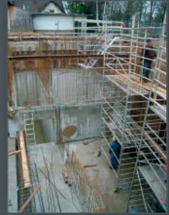
Travaux de coffrage et de bétonnage
