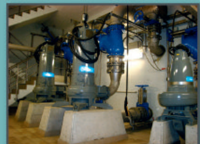
Pompes posées en cale sèche
