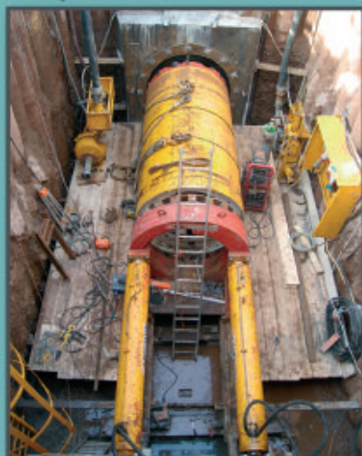
Fonçage en-dessous des voies CFL
