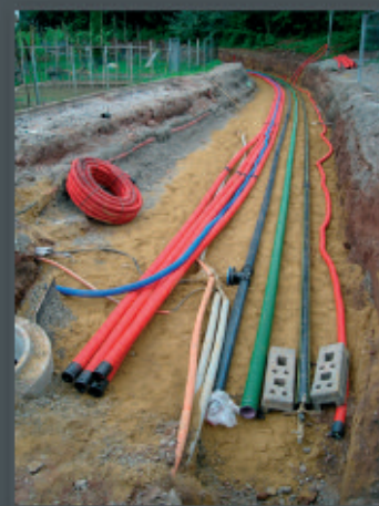
Gaines et diverses infrastructures
