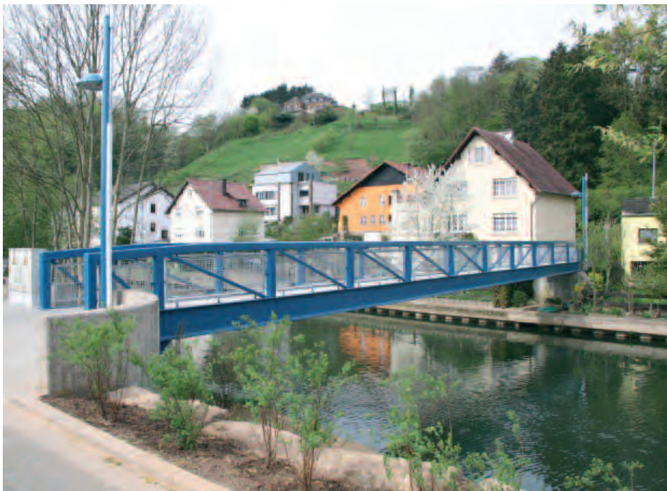
Die neue Fußgängerbrücke (Photo Pierrot Feltgen)
