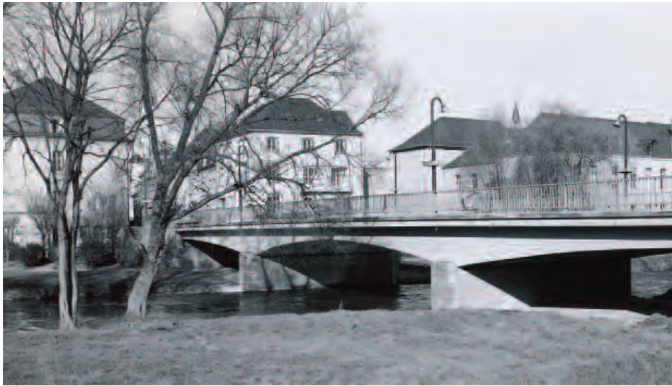
Die 1948 fertig gestellte Brücke (Photo Arthur Muller)
