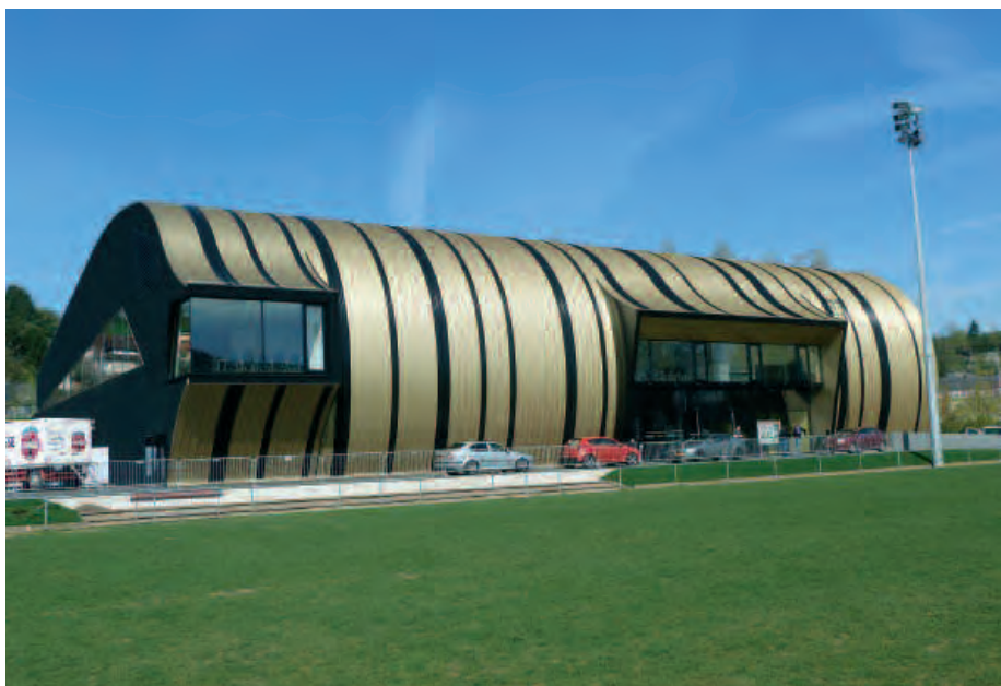
Am 1. April fand die Einweihung der neuen Deichhalle statt. (Photo Arthur Muller)
