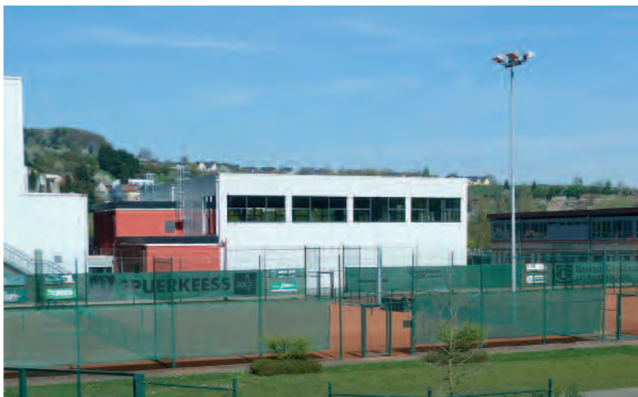
Seit 2009 ist die Turnhalle in Betrieb. (Photo Arthur Muller)
