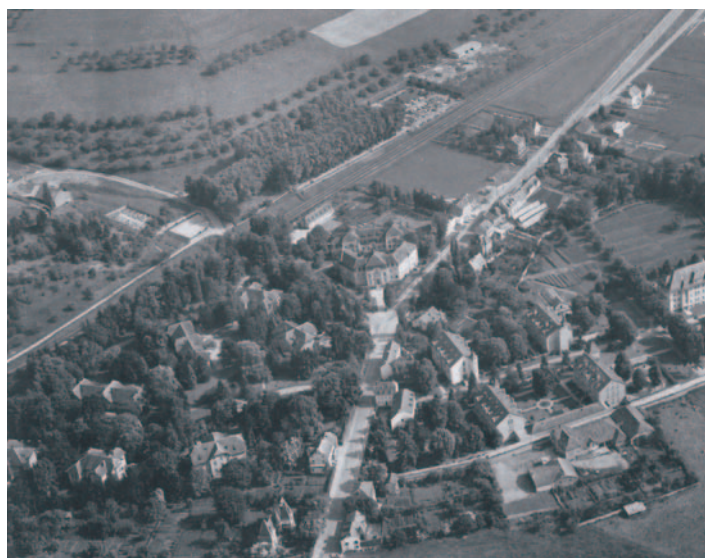
L'ensemble architectural du C.H.N.P. en 1960
