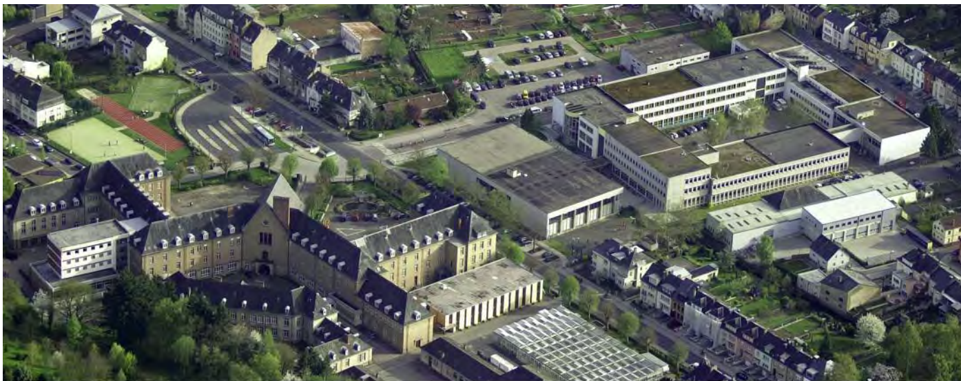
Les deux écoles de part et d'autre de l'avenue Salentyne: l'École Agricole à gauche et le Lycée Technique à droite (en 2011)
