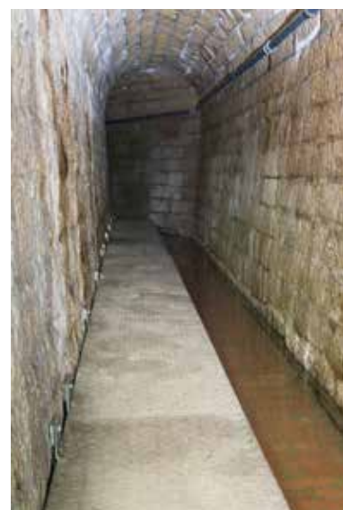
Die Brunnenkammer aus dem Jahre 1906 ist noch immer in Betrieb. Der Laufsteg auf der linken Seite ist jüngeren Datums. (Photo: Marco Brachtenbach)
