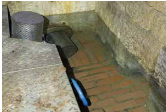
Durch die Schlitz- unten in der Wand (linkes Foto) fließt das Quellwasser in die Brunnenkammer. Auf dem rechten Foto der Abfluss des Wassers in die Leitung (Photos: Marco Brachtenbach)
