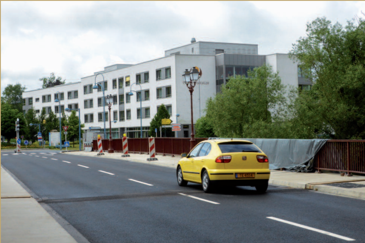
Nach Renovierungsarbeiten ist die Alzettebrücke für den Verkehr wieder befahrbar.
